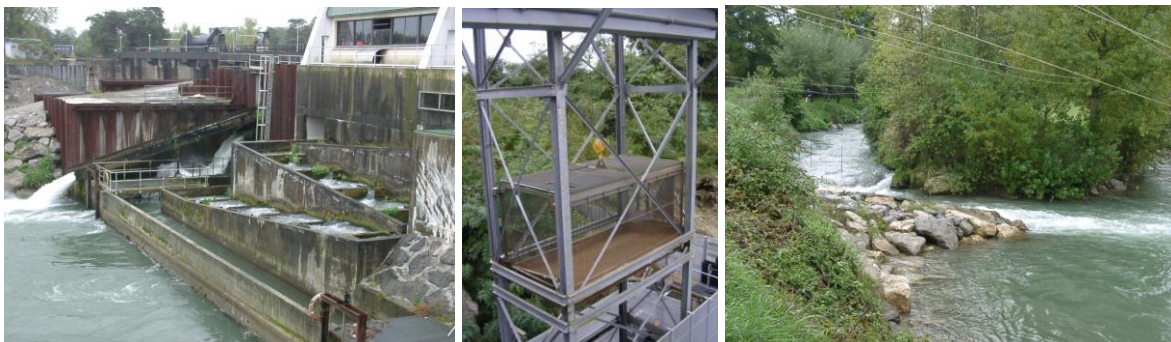
Figure 6 : Passe à bassin successifs sur le gave de Pau - Ascenseur à poissons sur le gave d'Ossau – Rivière artificielle sur le gave de Pau
