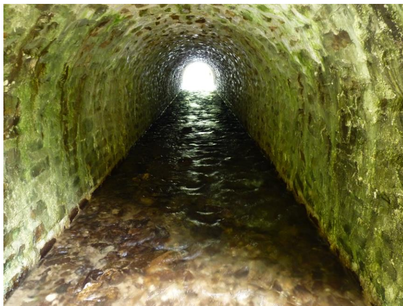
Passage sous pont en 2015
