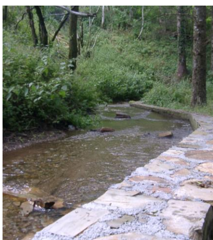
Fossé en 2005 après les travaux
