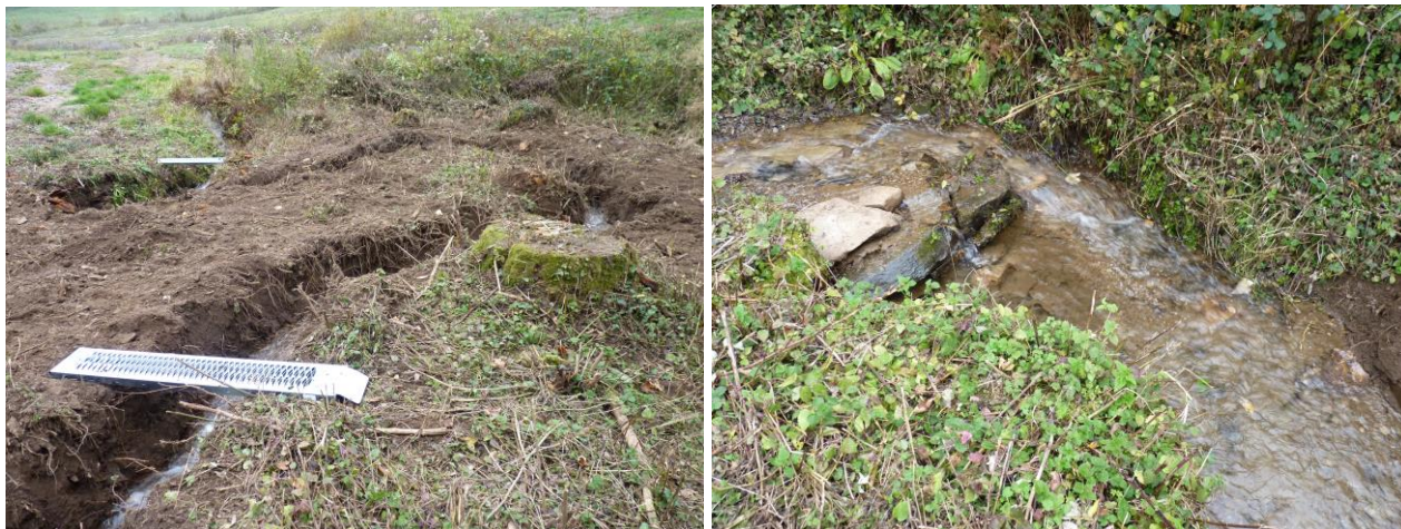
Passerelles sur nouvelle dérivation – Ancienne chute du virage
