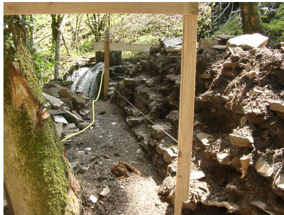
En début de restauration
