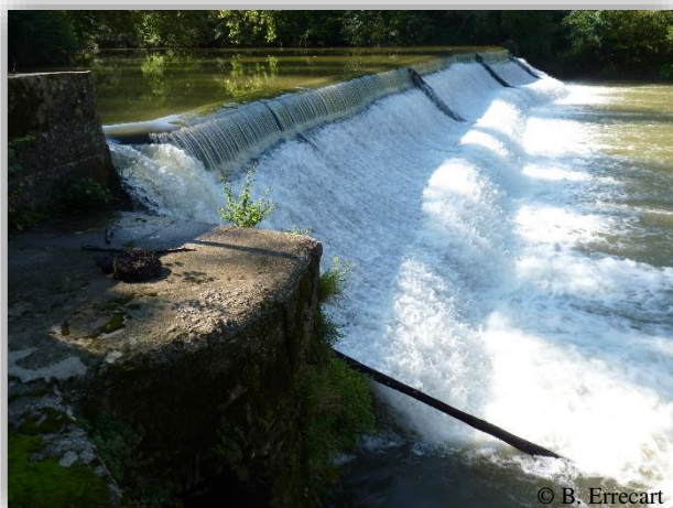
Figure 3 : Moulin de la Ramière, utilisé pour la production d'hydroélectricité
