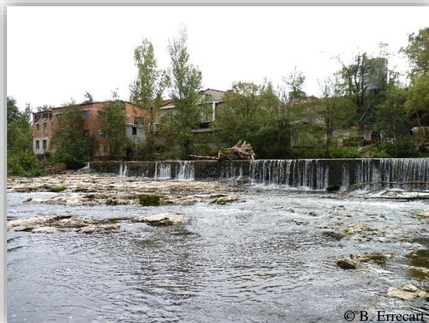
Figure 4 : Chaussée de Ricardens, utilisée actuellement pour alimenter un pompage
